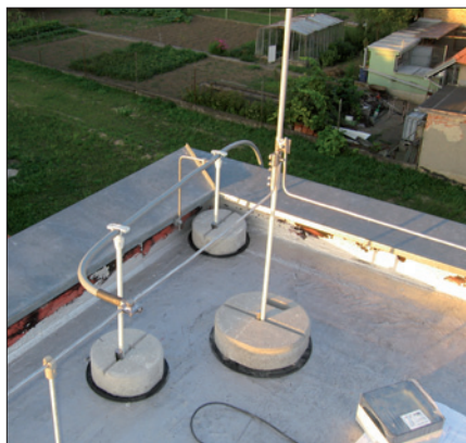
Obr. 3. Izolovaný hromosvod s HVlight
