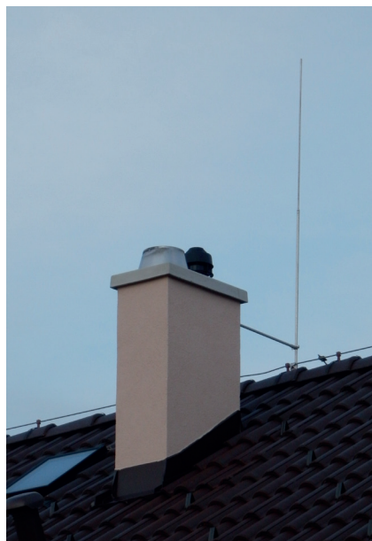
Obr. 4 Uchycení jímáče pomocí izolačního držáku DEHNiso Combi ke komínu stavby
