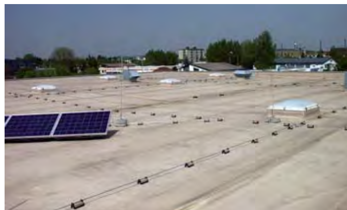
Obrázek 5.1.3.2 Aplikace jímacích tyčí
