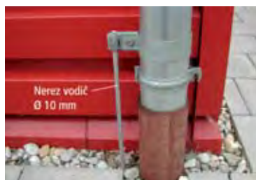
Obrázek 5.2.2.1.4 Uzemnění okapové roury
