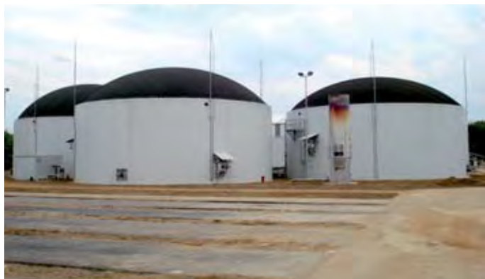
Obrázek 5.2.4.18 Ochrana fermentoru s vodičem HVI
