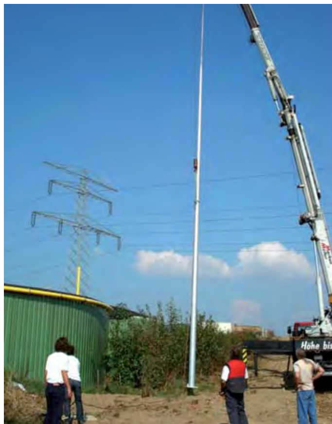
Obrázek 5.1.8.8 Vztyčování teleskopického stožáru pro ochranu před bleskem
