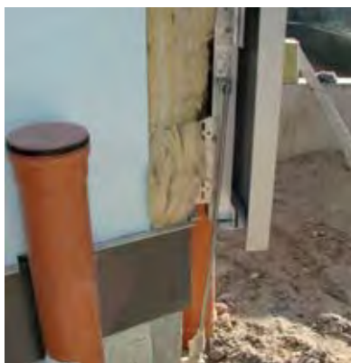
Obrázek 5.2.2.2.3 Uzemnění kovové fasády
