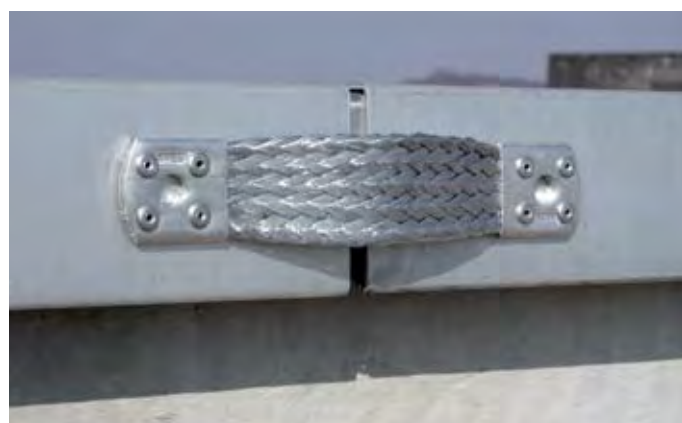
Obrázek 5.1.3.3 Propojení atiky
