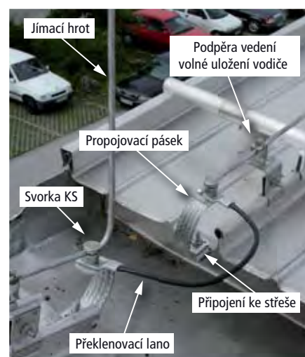
Obrázek 5.1.4.4b Podpěra vedení pro plechovou střechu - kulatý stojatý falc plechu
