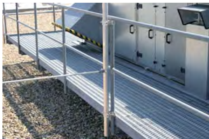
Obrázek 5.1.8.12 Podpurná trubka DEHNiso-Combi připevněná k zábradlí
