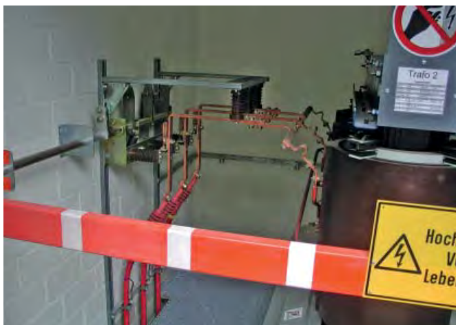
kobka vn s transformátorem
