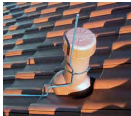
Obrázek 5.1.2.3 Doplňková jímací soustava pro odvodňovací potrubí
