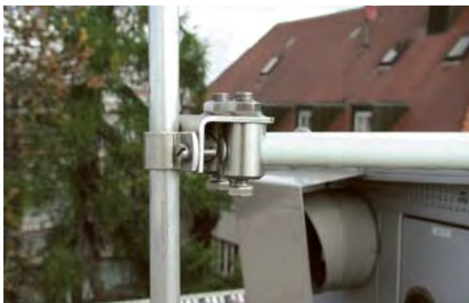
Obrázek 5.1.8.5 Uchytení jímací tyče
