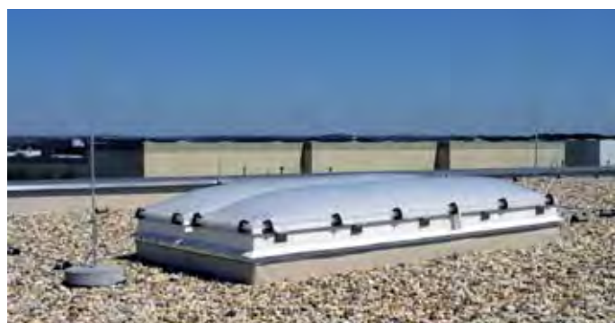
Obrázek 5.1.1.17 Ochrana menších střešních nástavců před přímými zásahy s jímacími tyčemi
