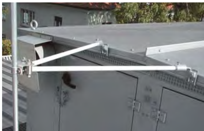
Obrázek 5.1.8.4 Uchytení jímací tyče úhlovou vzpěrou
