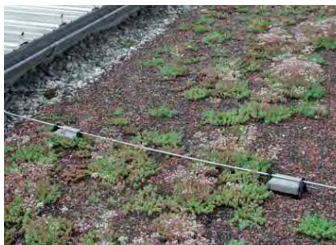
Obrázek 5.1.7.3 Instalace vedení nad krycí vrstvou
