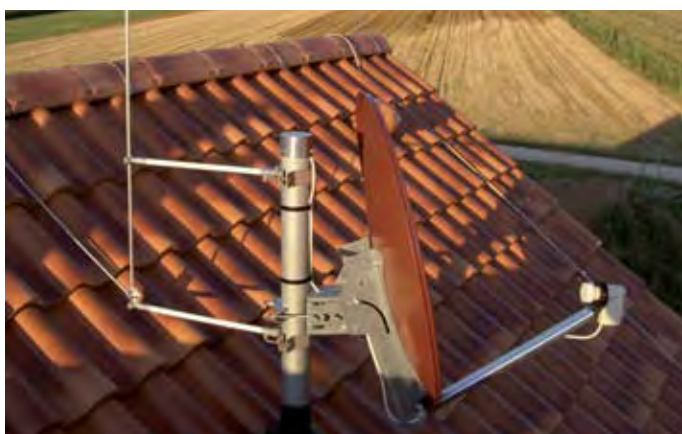
Obrázek 5.1.2.5 Anténa s jímací tyčí na izolovaných držácích
