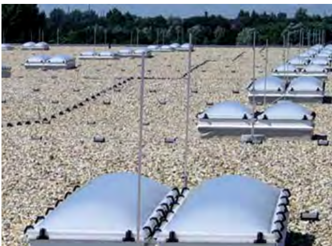
Obrázek 5.1.1.19 Plochá střecha s jímacími tyčemi a s drážky vedení: Ochrana světlíků.
