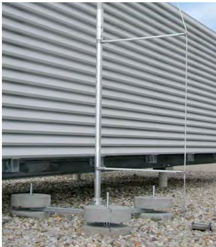
Obrázek 5.1.8.10 Tříramenný stojan pro volně stojící podpěrné trubky
