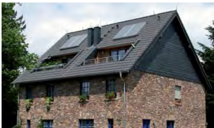
Obrázek 5.1.2.4 Budovy s fotovoltaickým zařízením a s dodrženou dostatečnou vzdáleností; Zdroj: Ochrana před bleskem Wettingfeld, Krefeld
