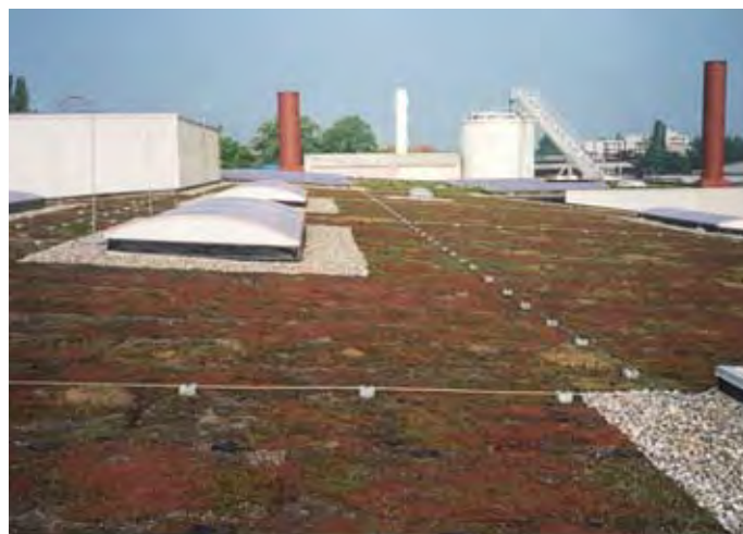
Obrázek 5.1.7.2 Jímací soustava na zatravněné střeše
