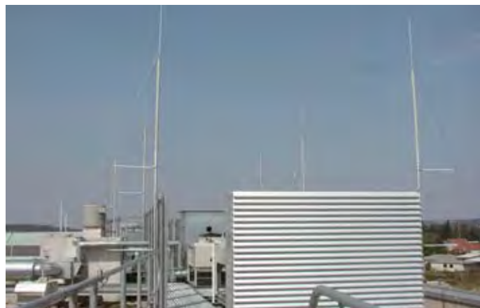
Obrázek 5.1.8.11 Oddálená jímací soustava s DEHNiso-Combi
