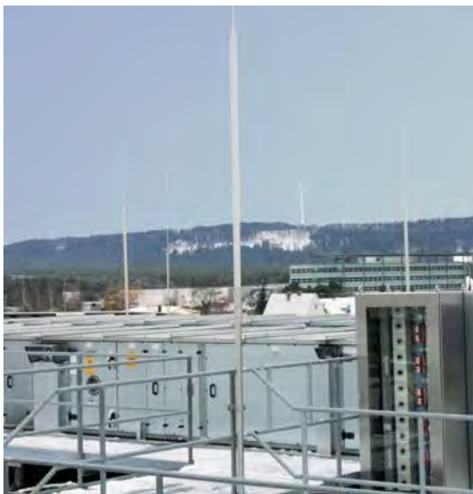
Obrázek 5.2.4.10 Instalace vodiče HVI-power
