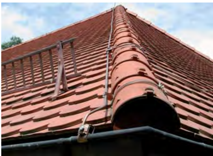
Obrázek 5.1.1.18 Sedlová střecha s drážkem vedení
