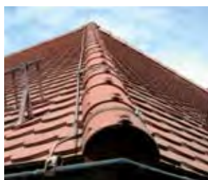
Obrázek 5.2.2.1.3 Jímací soustava s napojením na okapový žlab
