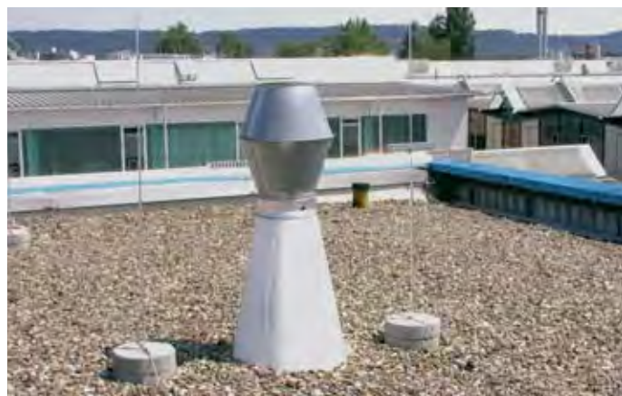
Obrázek 5.1.8.2 Oddálená jímací soustava - ochrana jímacími tyčemi
