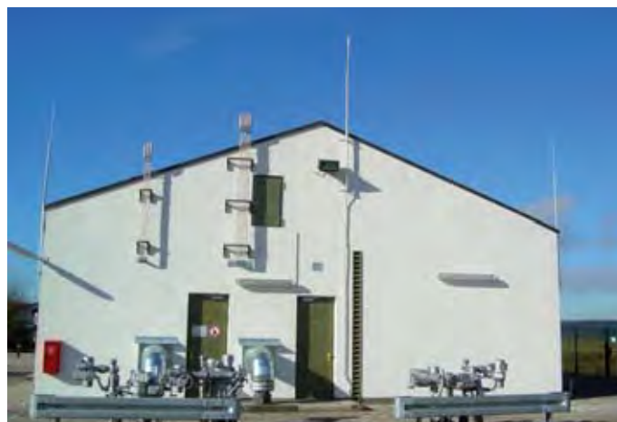
Obrázek 5.2.4.15 Montáž vodiče HVI na tlakové plynové stanici
