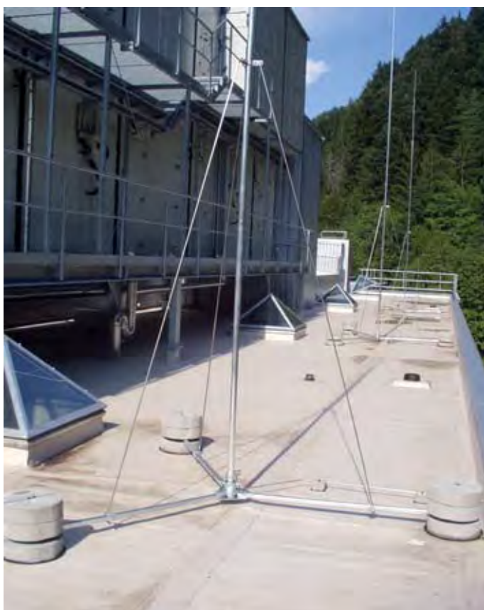
Obrázek 5.1.8.7 Oddálená jímací soustava pro střešní nástavby
