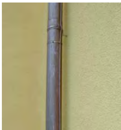
Obrázek 5.2.2.2.4 Svod na okapové rouře
