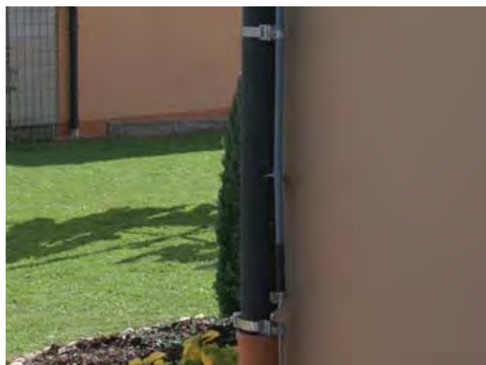
Obrázek 5.2.4.6 Připojení vodiče DEHNcon-H (HVI-light) na zemnicí soustavu
