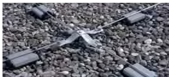
Obrázek 5.4.1.1 Jímací soustava – dilatační prvek s propojovacím páskem
