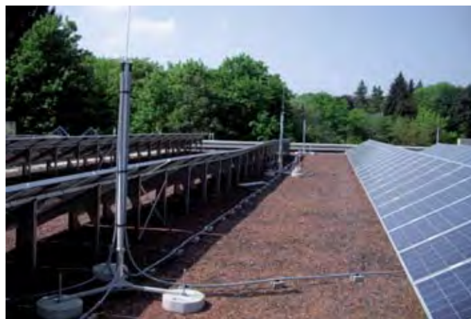
Obrázek 5.2.4.5 Ochrana FV zařízení pomocí vodiče HVI
