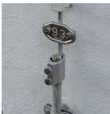
Obrázek 5.2.2.3.1 Zkušební svorka s číslem
