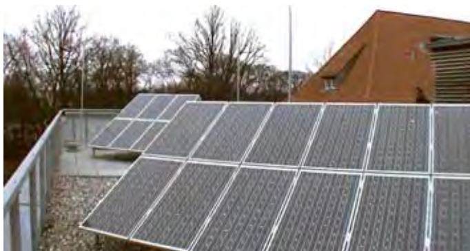
Obrázek 5.1.8.6 Oddálená jímací soustava pro fotovoltaiku
