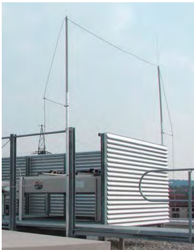
Obrázek 5.1.8.13 Oddálená jímací soustava s DEHNiso-Combi
