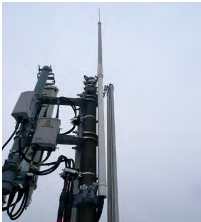
Obrázek 5.2.4.14 Montáž vodiče HVI na nosné trubce antény
