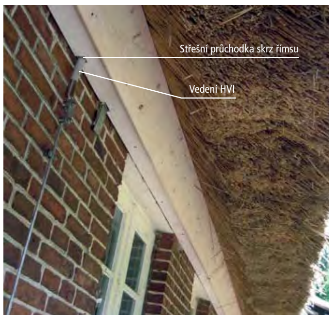
Obrázek 5.1.5.7 Vedení HVI skrz římsu
