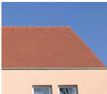
Obrázek 5.1.2.1 Jímací soustava na sedlové střeše
