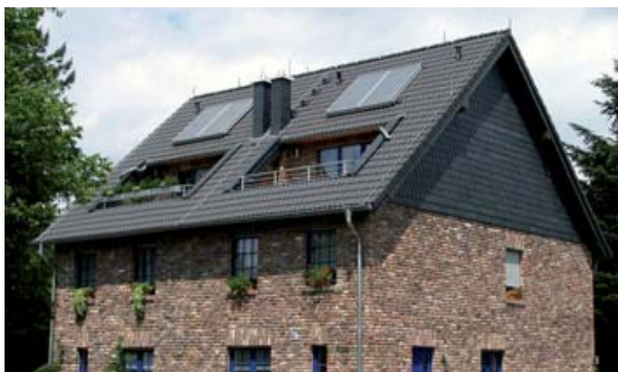
Obrázek 5.1.2.4 Budovy s fotovoltaickým zařízením a s dodrženu dostatečnou vzdáleností; Zdroj: Ochrana před bleskem Wettingfeld, Krefeld
