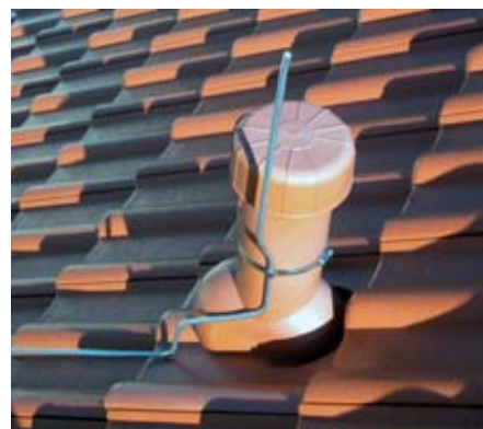
Obrázek 5.1.2.3 Doplňková jímací soustava pro odvodušňovací potrubí
