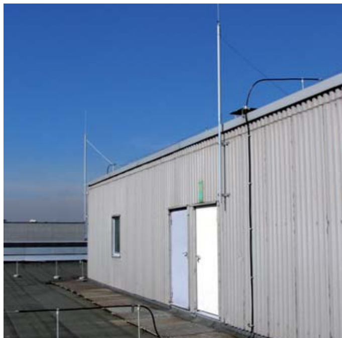
Obrázek 5.2.4.9 Instalace vodiče HVI s koncovkou
