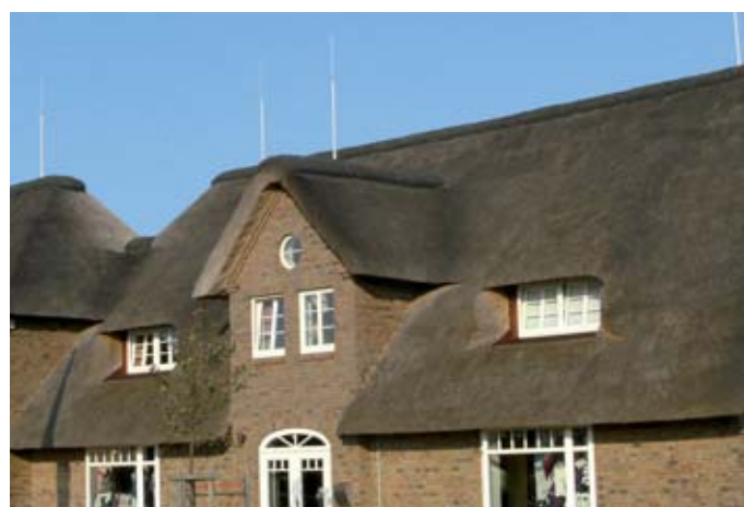
Obrázek 5.1.5.4 Historický selský dům s vnější ochranou před bleskem; Zdroj: Hans Thormählen GmbH & Co.KG.
