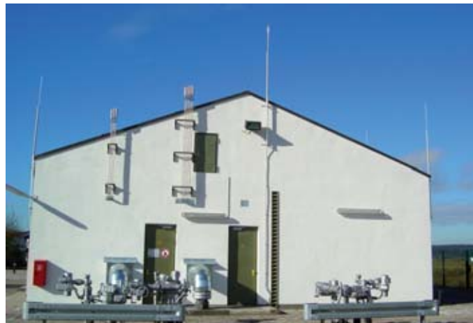
Obrázek 5.2.4.15 Montáž vodiče HVI na tlakové plynové stanici
