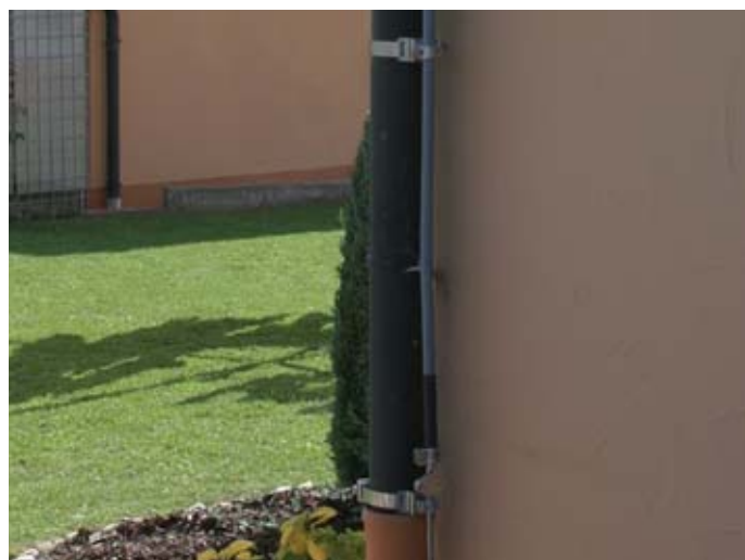
Obrázek 5.2.4.6 Připojení vodiče DEHNcon-H (HVI-light) na zemnicí soustavu
