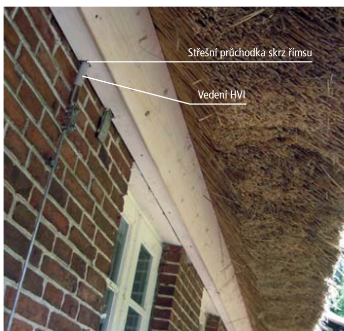
Obrázek 5.1.5.7 Vedení HVI skrz římsu
