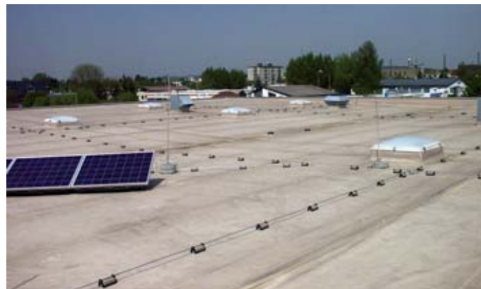
Obrázek 5.1.3.2 Aplikace jímacích tyčí
