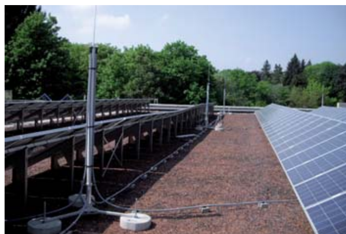
Obrázek 5.2.4.5 Ochrana FV zařízení pomocí vodiče HVI
