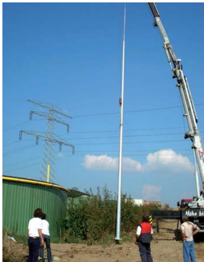
Obrázek 5.1.8.8 Vztyčování teleskopického stožáru pro ochranu před bleskem
