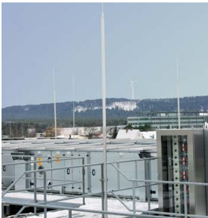
Obrázek 5.2.4.10 Instalace vodiče HVI-power
