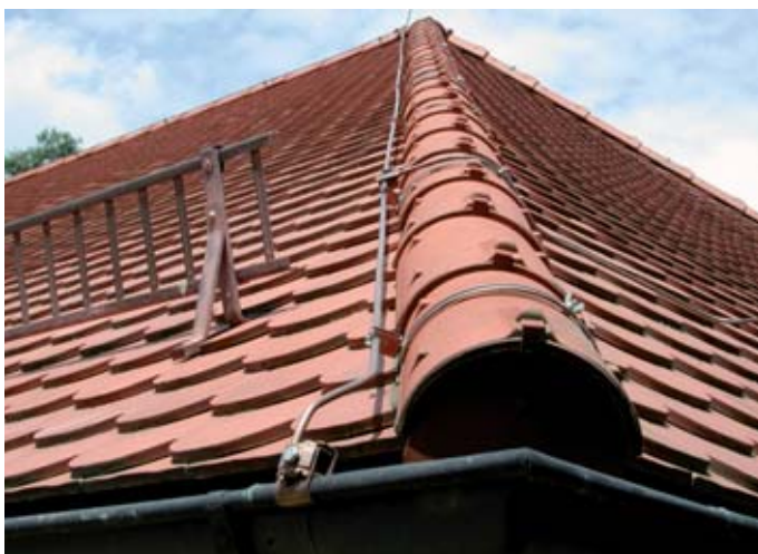
Obrázek 5.1.1.18 Sedlová střecha s držákem vedení
