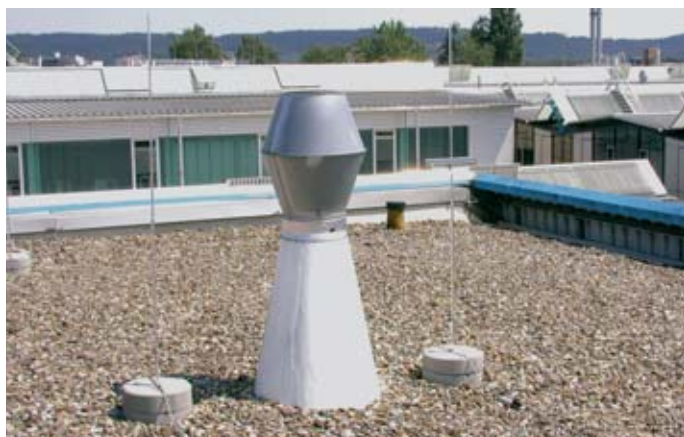
Obrázek 5.1.8.2 Oddálená jímací soustava - ochrana jímacími tyčemi
