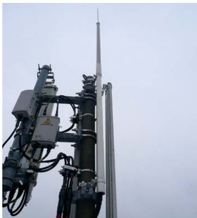
Obrázek 5.2.4.14 Montáž vodiče HVI na nosné trubce antény
