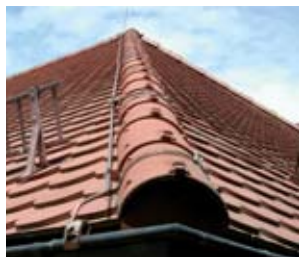
Obrázek 5.2.2.1.3 Jímací soustava s napojením na okapový žlab
