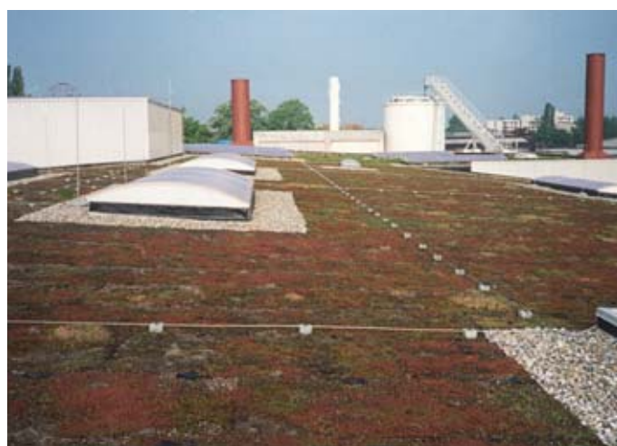
Obrázek 5.1.7.2 Jímací soustava na zatravněné střeše
