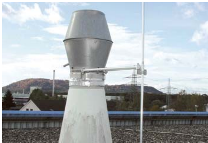
Obrázek 5.1.8.3 Jímací tyč s izolovaným držákem
