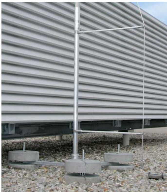
Obrázek 5.1.8.10 Tříramenný stojan pro volně stojící podpěrné trubky
