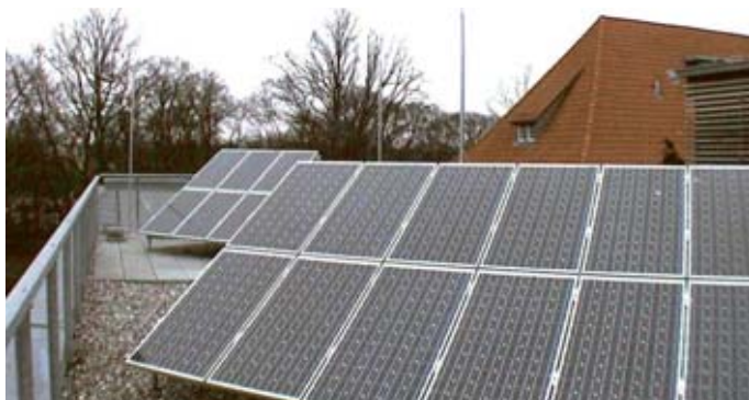
Obrázek 5.1.8.6 Oddálená jímací soustava pro fotovoltaiku
