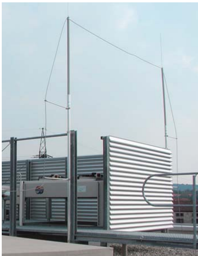
Obrázek 5.1.8.13 Oddálená jímací soustava s DEHNiso-Combi
