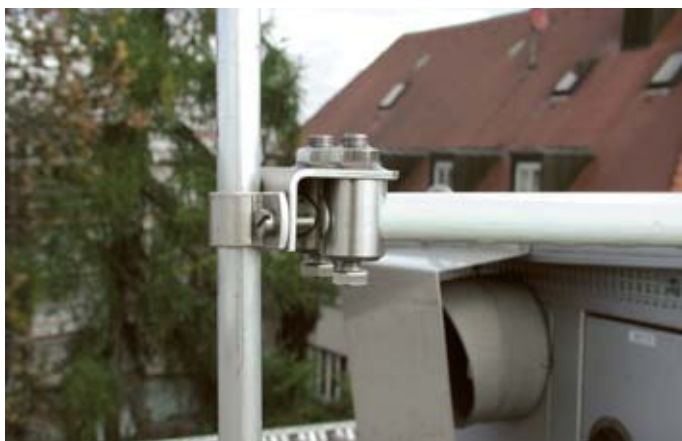
Obrázek 5.1.8.5 Uchytení jímací tyče
