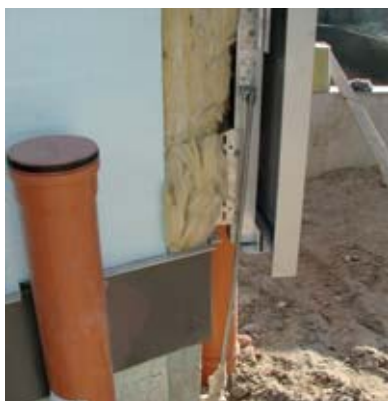
Obrázek 5.2.2.2.3 Uzemnění kovové fasády
