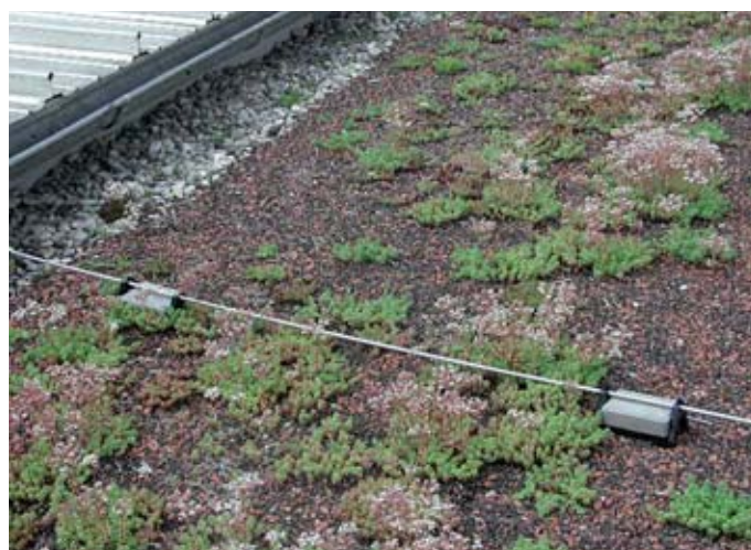
Obrázek 5.1.7.3 Instalace vedení nad krycí vrstvou
