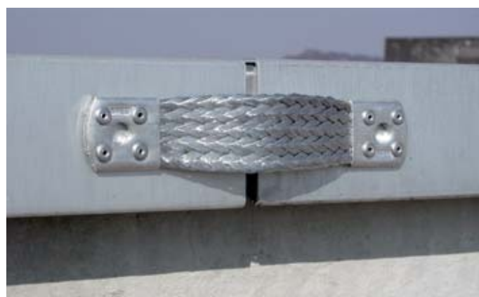
Obrázek 5.1.3.3 Propojení atiky
