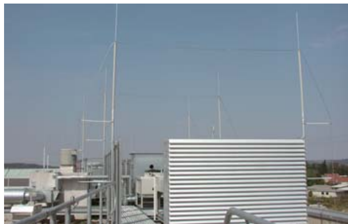
Obrázek 5.1.8.11 Oddálená jímací soustava s DEHNiso-Combi
