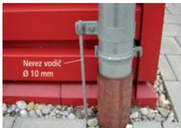
Obrázek 5.2.2.1.4 Uzemnění okapové roury
