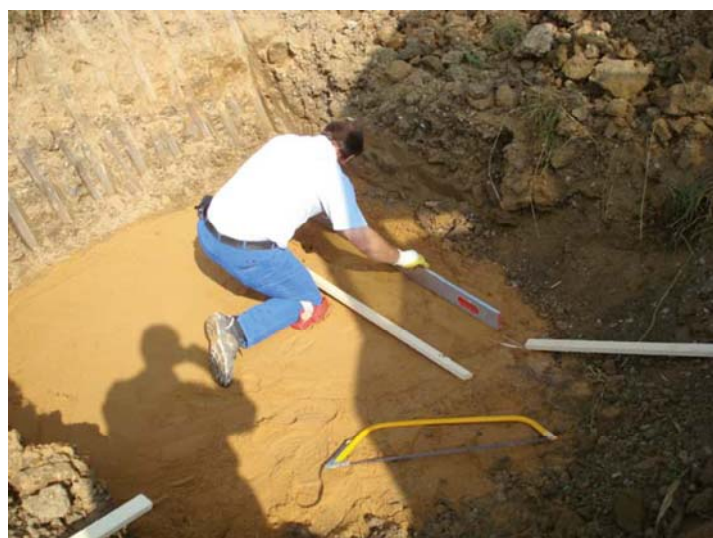
Obr. 3a Základová jáma s pískovým ložem
