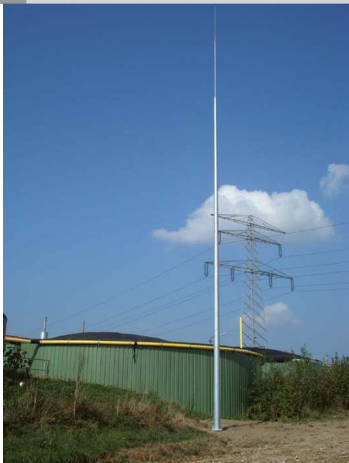
Obr. 2 Bioplynová stanice s teleskopickým jímacím stožárem
