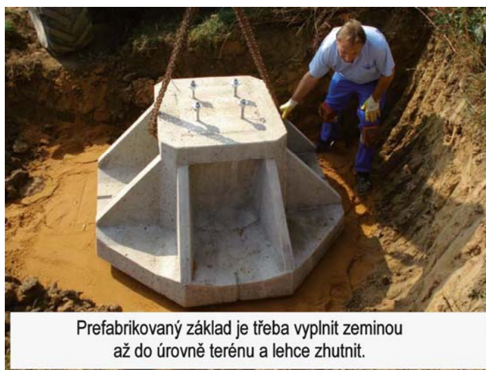
Obr. 3b Prefabrikovaný základ KöFU I
