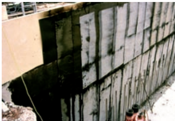
Izolace z asfaltové fólie
