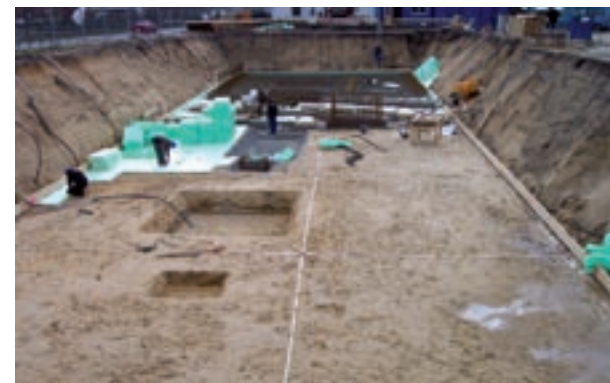
Obvodový zemnič u obvodové izolace
