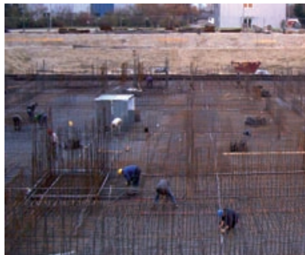
Základový zemnič uspořádaný do mřížové soustavy
