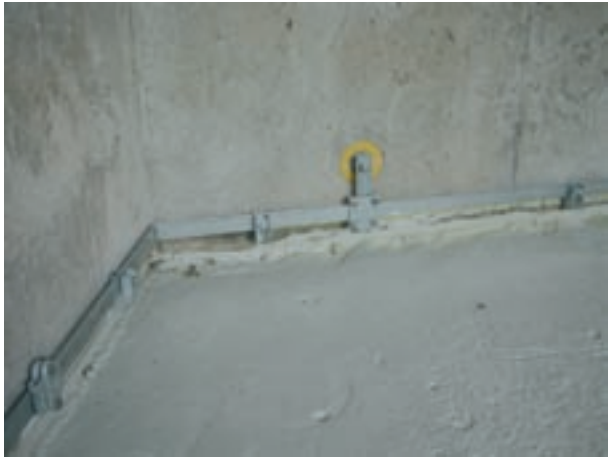
Okružní sběrnice pro vyrovnání potenciálů
