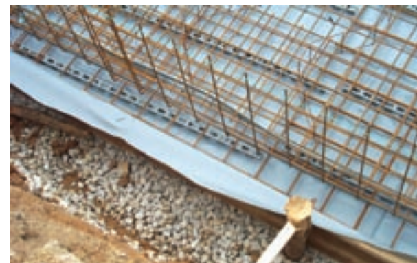
Fólie na základové desce
